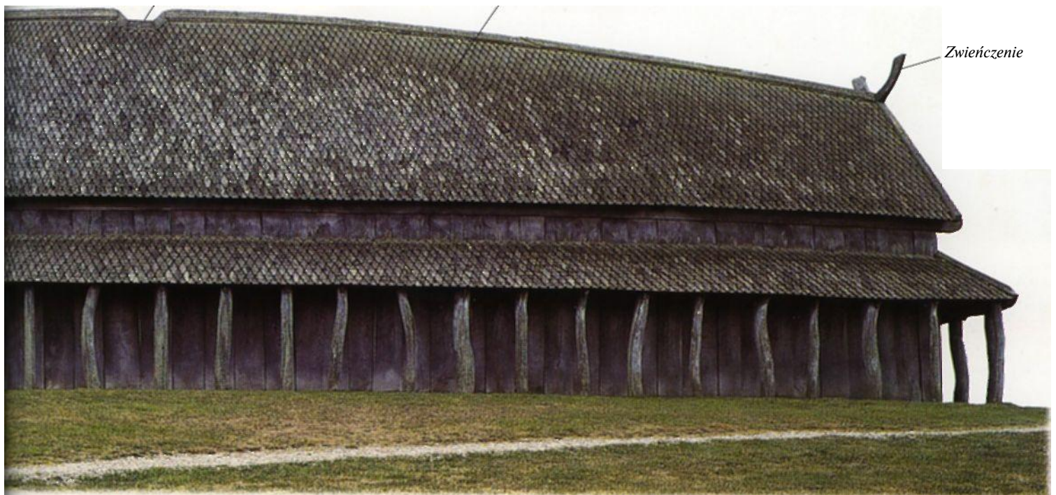
Dach pokryty drewnianym gontem
