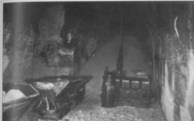
Bunkier V2 w Wizernes po 10 maja 1997 roku. Fotografia przedstawia wnętrze tunelu kolejowego „Ida” (tuż za bocznym tunelem „Mathilde”). Widać wagoniki używane na budowie, sprężarkę powietrza systemu wentylacyjnego i skutki zawału spowodowanego przez brytyjskich saperów w 1944 roku
