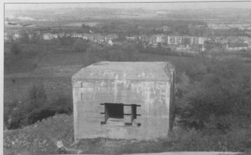
Bunkier V2 w Wizernes: wywietrznik tunelu kolejowego umieszczony na szczycie kopuły. Zdjęcie wykonane przed 10 maja 1997 roku
