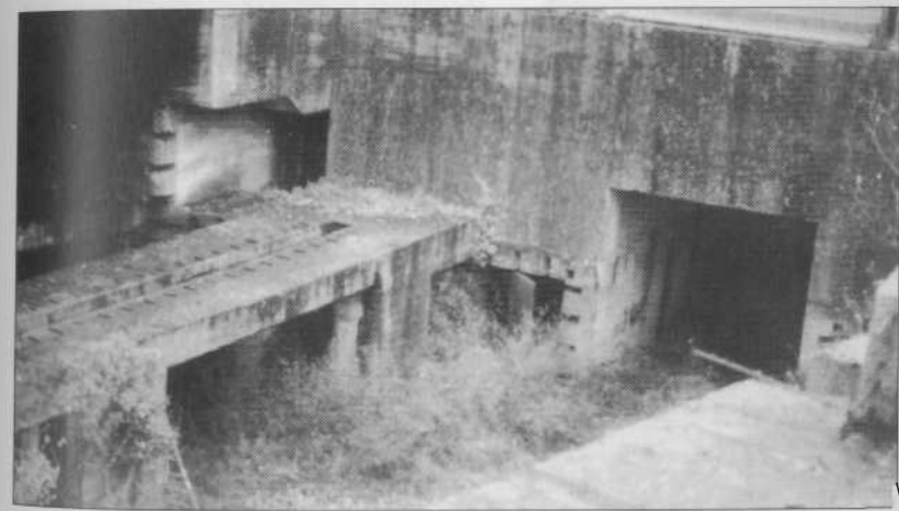
Brécourt, stanowisko składowania i startów W/V2/Rheinböte. Rakiety wyjeżdżały z podziemnych pomieszczeń znajdujących się pod wzgórzem (z lewej). Widać też platformę startową V2/Rb i otwór nachylonego pod kątem tunelu odprowadzającego gazy wylotowe
