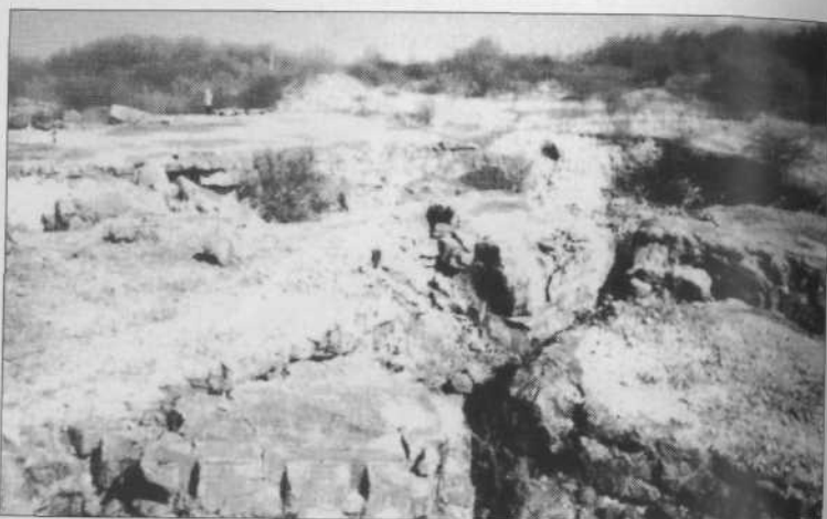
Stanowisko HDP w Mimoyecques. Zniszczona płyta nad systemem tuneli z otworami wylotowymi luf. W każdym z trzech otworów znajdowały się lufy pięciu studwudziestometrowych luf wycelowanych w Londyn. Postać widoczna w tle daje wyobrażenie o rozmiarach budowli
