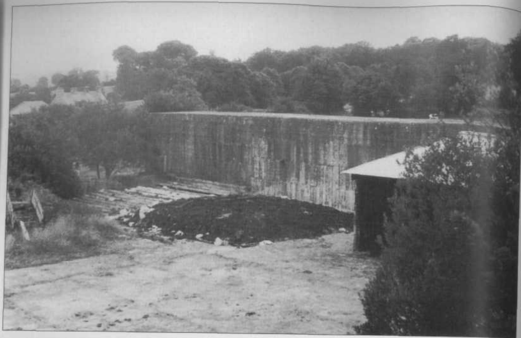
Bunkier V2 w Sottevast (patrz ilustracja 13). Strop bunkra miał zakryć cały teren na pierwszym planie. Wspierałyby się na ścianie widocznej na zdjęciu i dwóch podobnych, które miały znajdować się po przeciwnej stronie, ale nie zostały zbudowane. Przykryta betonowymi belkami platforma startowa rakiet znajduje się na głębokości 18-24 metrów
