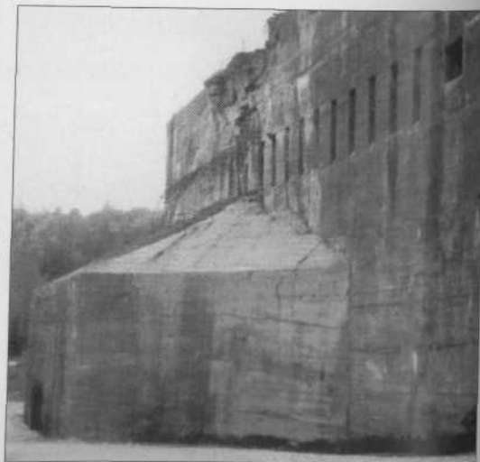
Bunkier V2 w Watten: częściowo zablokowana zachodnia brama kolejowa prowadząca do głównego budynku. Wysunięty element zapewniał osłonę przesuwnym bomboodpornym wntom o grubości 2,25 m
