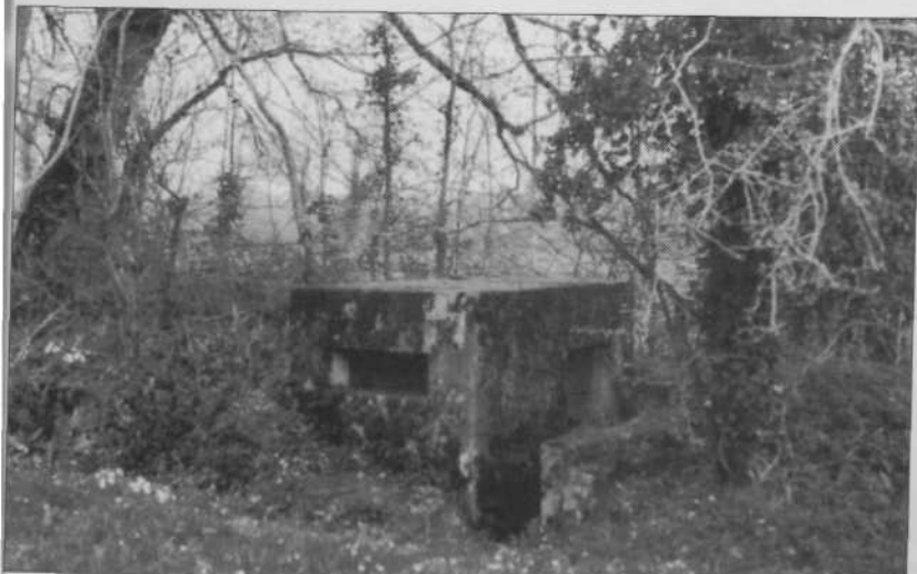
Proste stanowiska: Le Quesnoy. Bunkier dowodzenia startami W/Rheinbóte. Platforma startowa znajduje się w odległości 9 metrów od szczeliny obserwacyjnej
