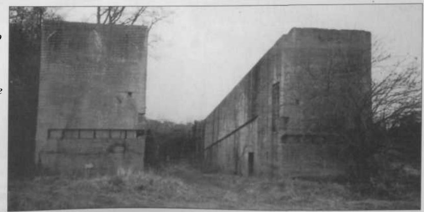
Brécourt, stanowisko składowania i startów W/V2/Rheinböte. Rakiety wyjeżdżały z podziemnych pomieszczeń znajdujących się pod wzgórzem (z lewej). Widać też platformę startową V2/Rb i otwór nachylonego pod kątem tunelu odprowadzającego gazy wylotowe
