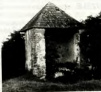
Jalowe – ruina kaplicy
