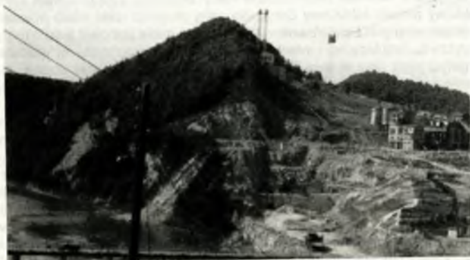
zapora w Solinie w trakcie budowy (1963)
