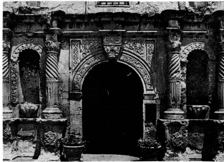
Wykruszony przez czas portal wejściowy El Alamo
