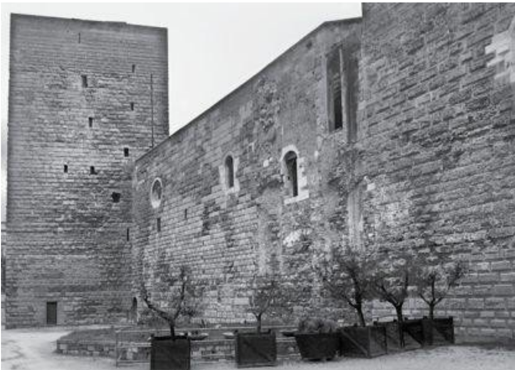
Posępne mury zamku w Bari i opustoszały dziedziniec. Stan obecny
