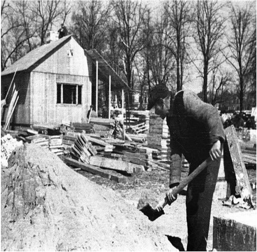
Budowa domków fińskich, Warszawa, kwiecień 1945 roku
