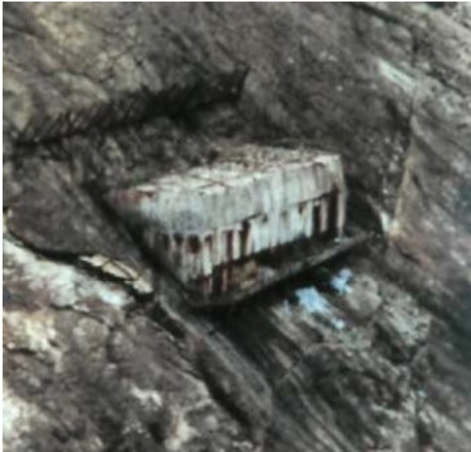
3. Ten reaktor obudowano ochronnym płaszczem z betonu.
