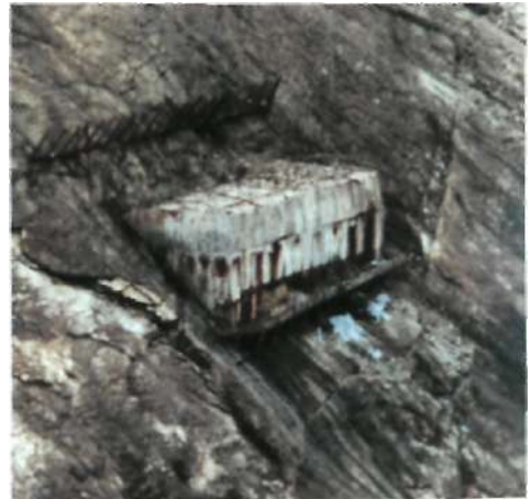
3. Ten reaktor obudowano ochronnym płaszczem z betonu.
