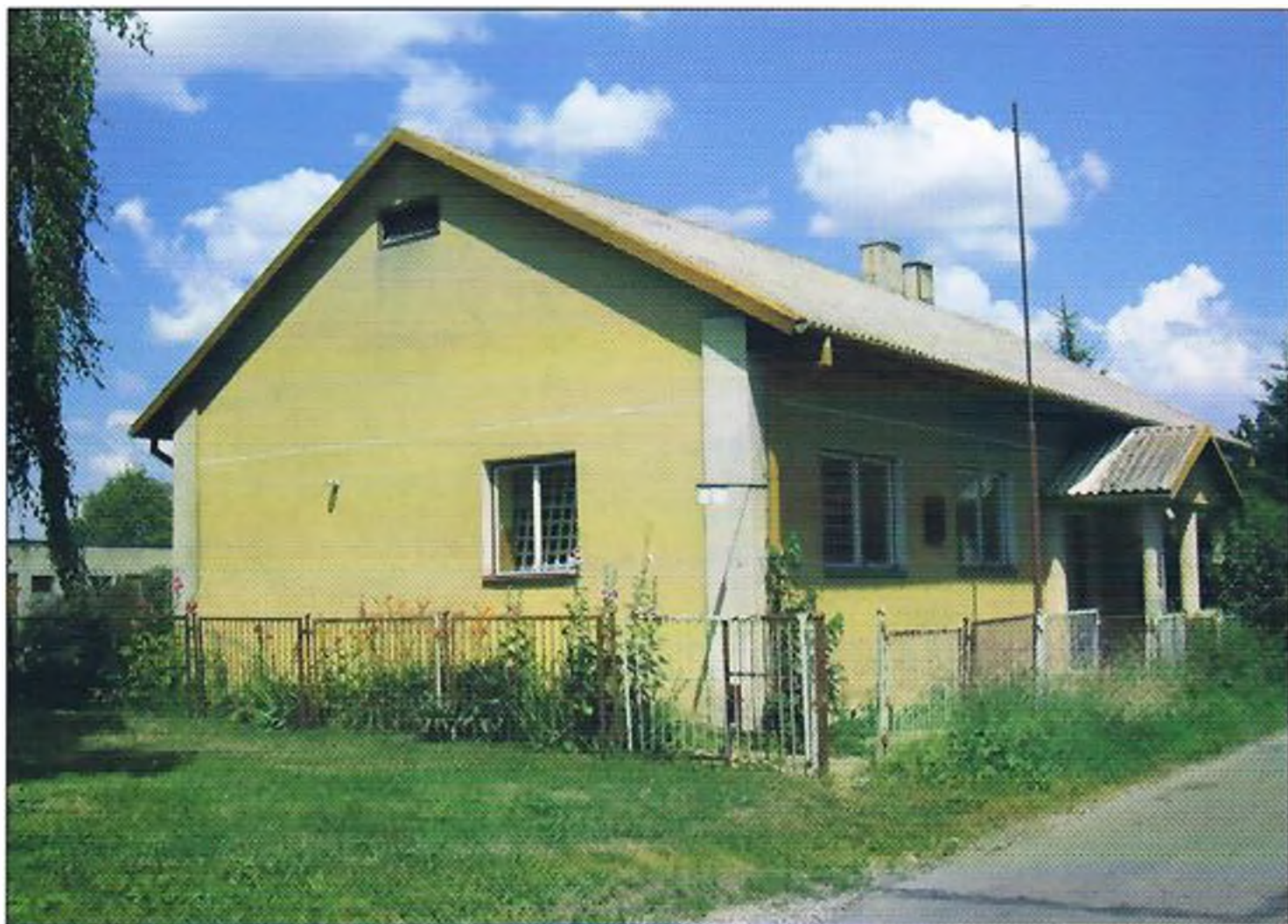
Budynek zamkniętej w 2005 roku Szkoły Podstawowej im. Mjr. Jana Piwnika „Ponurego” w Janowicach
