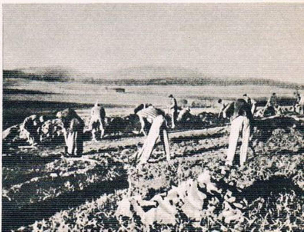
Pierwsze roboty ziemne przy budowie obozu. 1940 r.
