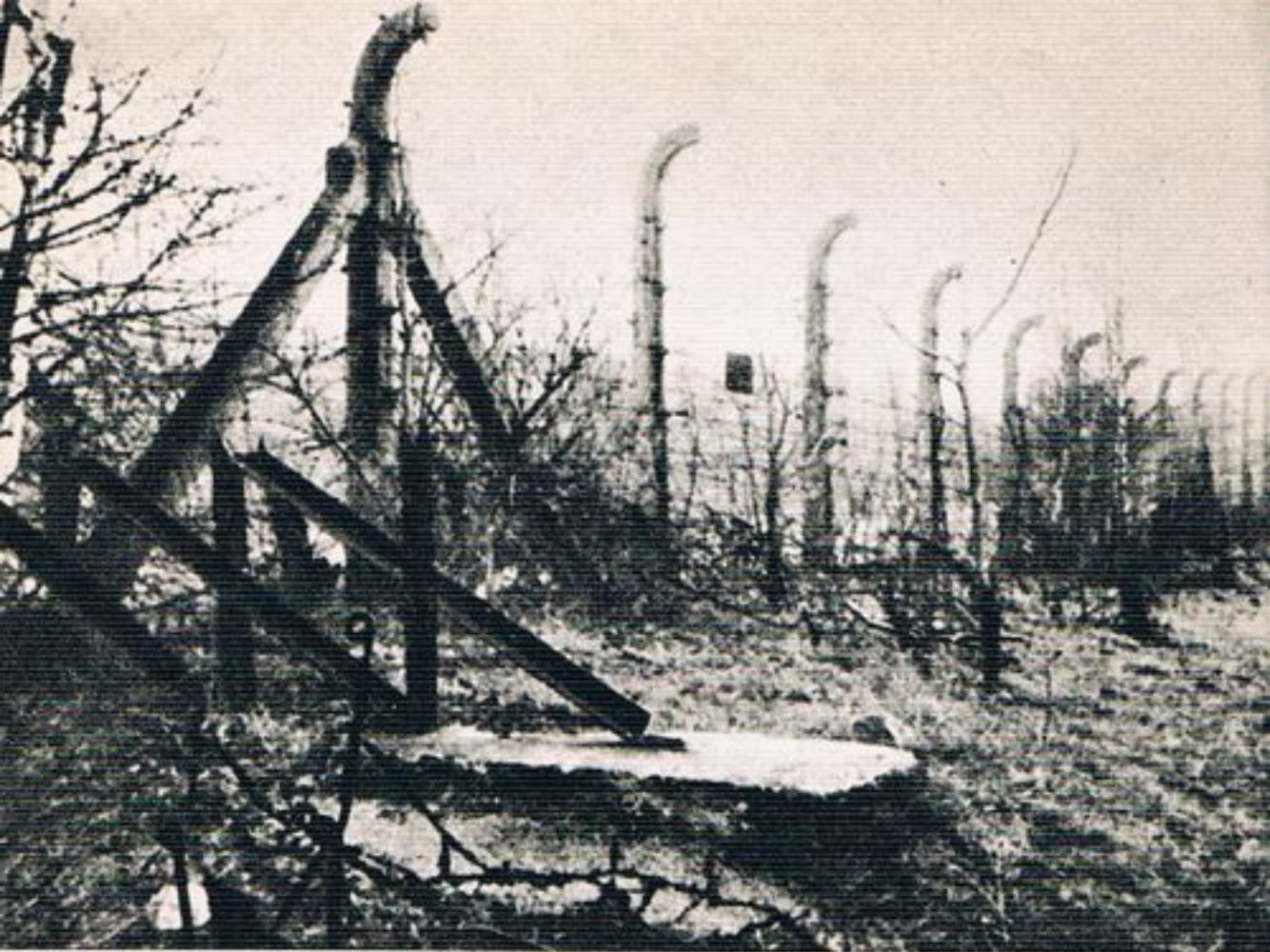
Druty wysokiego napięcia. Stan niekompletny z roku 1962
