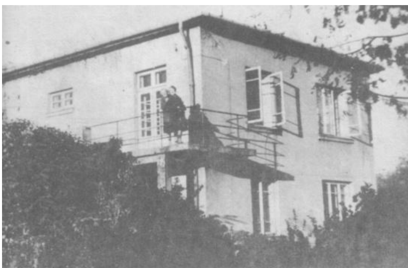
„Odzyskajcie wszelką nadzieję, wy, którzy tu wchodzić”. Dom w Gołąbkach.
