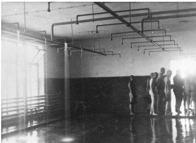
Prysznice w budynku Sauny w Birkenau
