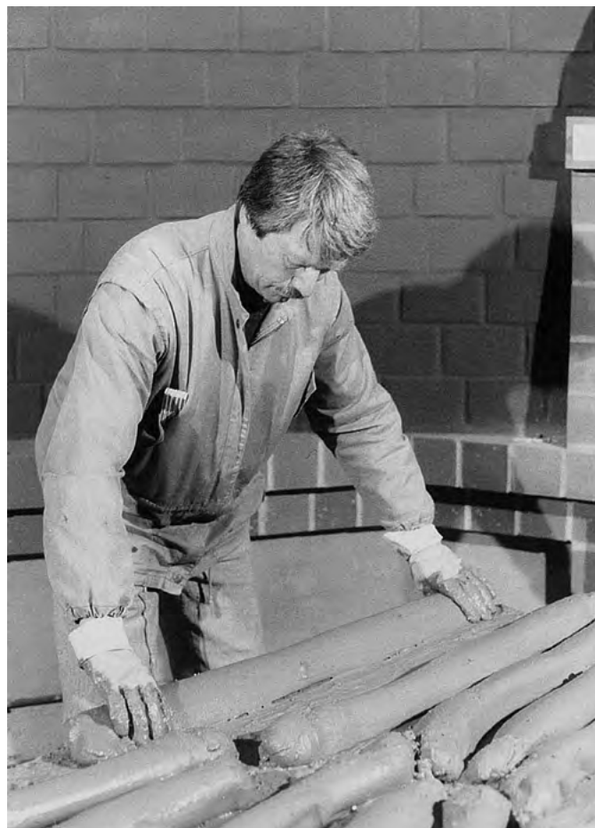
10.8-4 BUDOWA ŚCIANY ŁAZIENKI Z NAPEŁNIONYCH GLINĄ RĘKAWÓW
