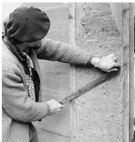
5.5-1 OBRÓBKA WILGOTNEJ GLINOBITKI PO ROZDESKOWANIUTECHNIKI PIŚE, FRANCJA
