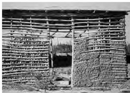
9.2-1 TRADYCYJNA KONSTRUKCJA ŚCIANY OBRZUCONEJ GLINĄ, WENEZUELA
