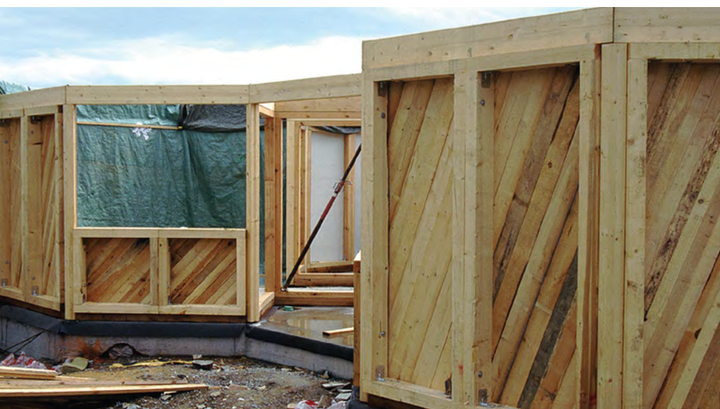
ELEMENT RAMY DREWNIANEJ WYPEŁNIONY GLINĄ UKŁADANY DO WYSUSZENIA
