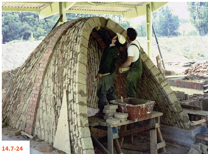
14.7-24 | 14.7-25 BUDOWA SKLEPIENIA NUBIJSKIEGO ZE ŚRODKOWYM ŁUKIEM DO OPARCIA
