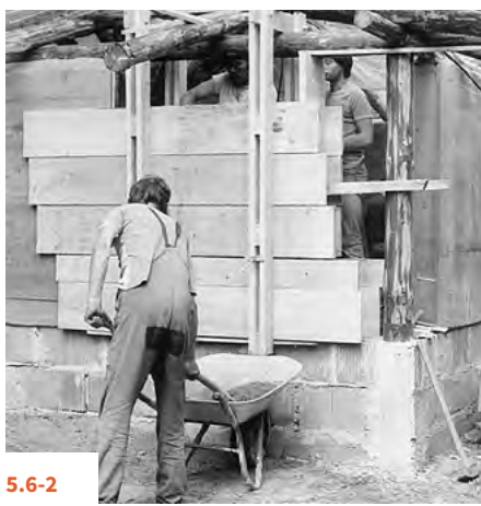
5.6-1 DO 5.6-3 SYSTEMY DESKOWANIA ŚLIZGOWEGO STOSOWANEGO PRZY METODZIE ELEMENTOWEJ
