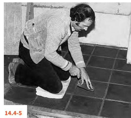
14.4-3, 14.4-4 | 14.4-5 WYKONYWANIE POSADZKI Z UBIJANEJ GLINY ORAZ PÓŹNIEJSZE UTWARDZANIE JEJ POWIERZCHNI
