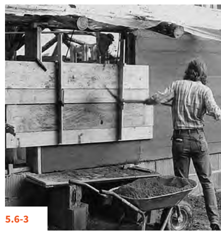
5.6-1 DO 5.6-3 SYSTEMY DESKOWANIA ŚLIZGOWEGO STOSOWANEGO PRZY METODZIE ELEMENTOWEJ
