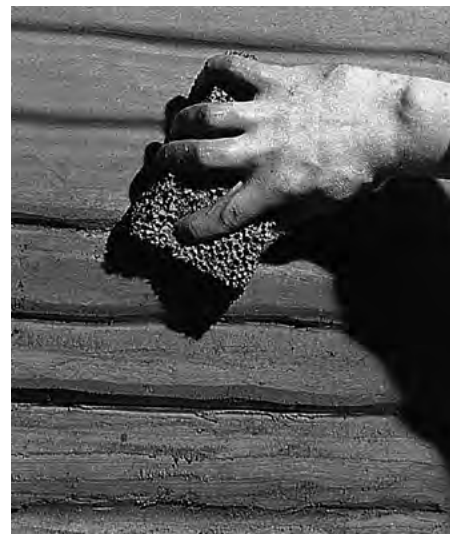
8.4-12 WYGŁADZANIE ŚCIANY Z PASM GLINIANYCH
