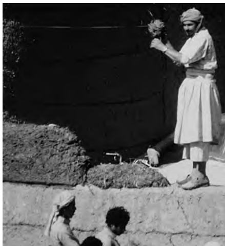
8.2-7 | 8.2-8 BUDOWANIE ŚCIAN GLINIANYCH TECHNIKĄ „ZABUR”
