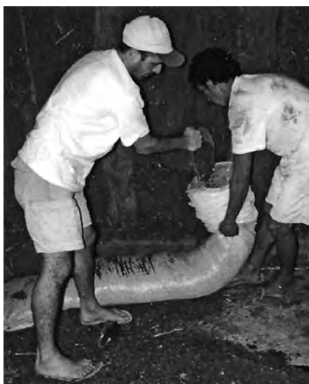
14.2-6 NAPEŁNIANIE RĘKAWÓW ZIEMIĄ
