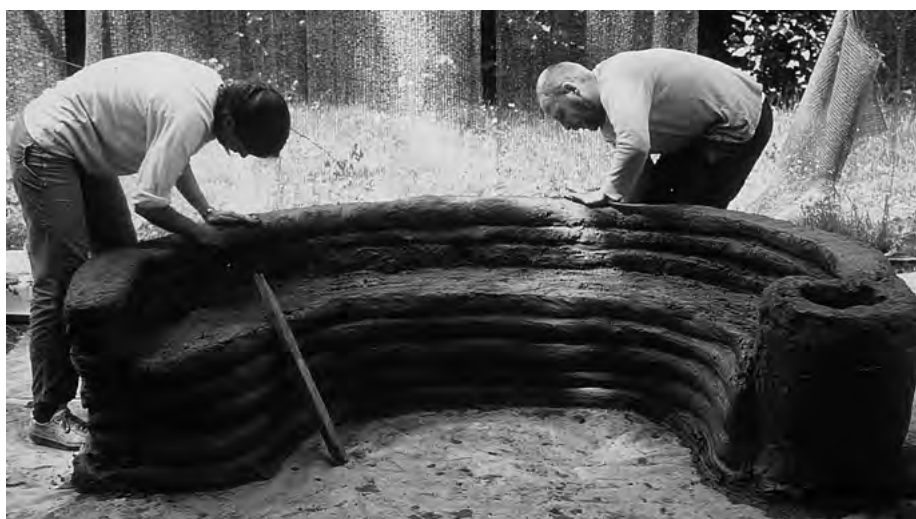
8.1-1 UKŁADANIE ŁAWKI Z PLASTYCZNEJ GLINY W FORMIE PASM
