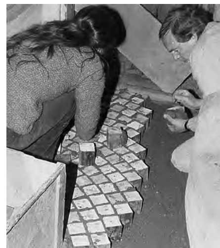
14.4.6 WYKONYWANIE POSADZKI GLINIANEJ Z CZOŁOWYMI KLOCKAMI DREWNIANYMI
