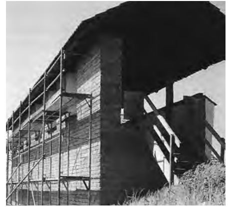
1.2-6 REKONSTRUKCJA ŚCIANY Z CEGIEŁ GLINIANYCH, VI WIEK P.N.E., HEUNEBURG, NIEMCY
