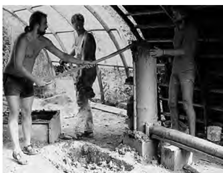
8.4-1 STOJĄCE URZĄDZENIE DO WYCISKANIA PASM GLINIANYCH, PROTOTYP FIRMY HEUSER
