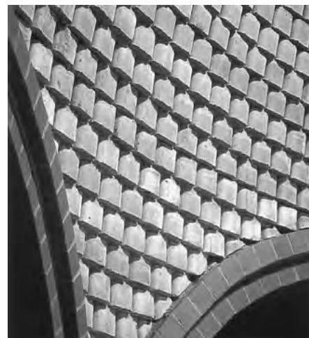
6.11-1 WIDOK DETALU: SKLEPIENIE Z AKUSTYCZNYCH CEGIEŁ GLINIANYCH
