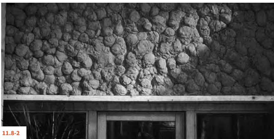
11.8-1 | 11.8-2 TYNKG GLINIANY, NARZUCANY WYKONANY W CELU ZWIĘKSZENIA REGULACJI WILGOTNOŚCI I CIEPŁA W OGRODZIE ZIMOWYM
