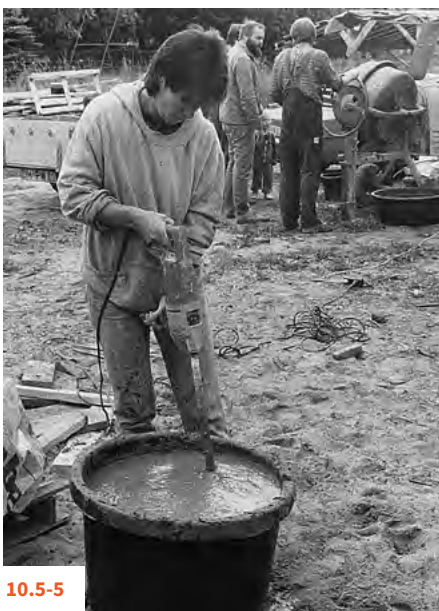
10.5-5 PRZYGOTOWYWANIE SZLAMU GLINIANEGO MIESZARKĄ RĘCZNĄ
