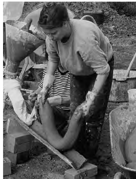
10.8-3 NAPEŁNIANIE BAWĘLIANEGO RĘKAWA GLINĄ LEKKĄ PRZY POMOCY LEJA
