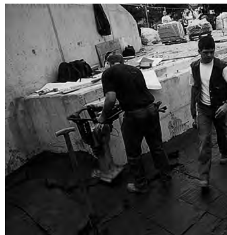
14.14-2 UKŁADANIE PREFABRYKATÓW GLINIANYCH JAKO ELEMENTÓW USZCZELNIAJĄCYCH STAW (FIRMA DIEKMANN, PEINE, NIEMCY)
