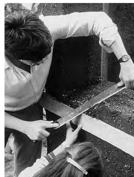
10.5-2 WYKONYWANIE NOŻEM SKOSÓW PARAPETU
