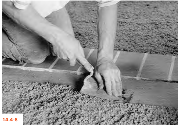
14.4-7 DO 14.4-8 KŁADZENIE I WYKOŃCZANIE POSADZKI Z NASYPYWANEJ, NADAJĄCEJ SIĘ DO CHODZENIA I ODPORNEJ NA ŚCIERANIE ZAPRAWY Z GLINY LEKKIEJ
