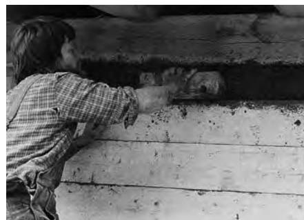
10.5-8 UCISKANIE OSTATNIEJ, NARZUCONEJ WARSTWY W NIEZADESKOWANYM MIEJSCU
