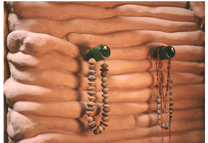
14.10-3 PLASTYCZNIE UFORMOWANA ŚCIANA Z PASM GLINIANYCH, STANOWIĄCA TYŁ ŁÓŻKA
