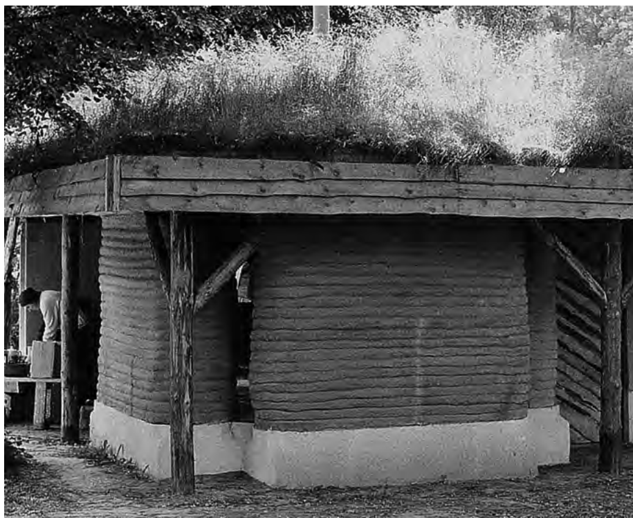
8.4-3 ZASTOSOWANIE METODY PASM Z GLINY PRZY BUDYNKU EKSPERYMENTALNYM, UNIWERSYTET KASSEL, 1982
