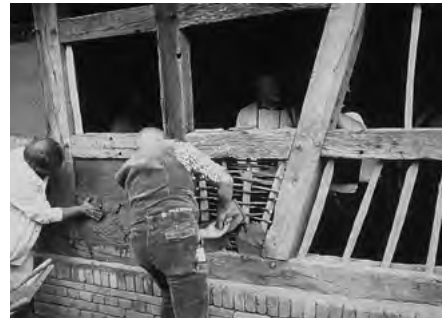
9.2-2 WYPEŁNIANIE PRZESTRZENI MIĘDZYBELKOWYCH GLINĄ ZMIESZANĄ ZE SŁOMĄ W HISTORYCZNEJ KONSTRUKCJI, SKANSEN KOMMERN
