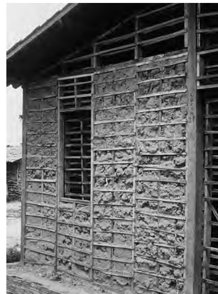
9.4-2 PREFABRYKOWANE ELEMENTY SZKIELETU DREWNIANEGO WYPEŁNIONEGO GLINĄ, BRAZYLIA
