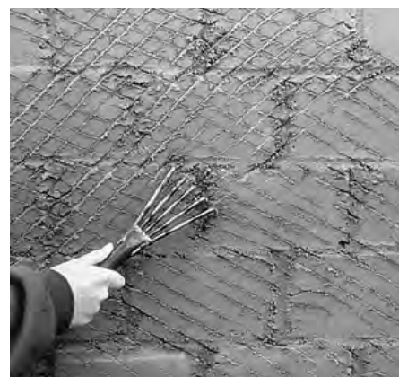
11.2-2 RYSOWANIE NAWILGOCONEJ POWIERZCHNI GLINIANEJ PRZY POMOCY STALOWEGO DRAPACZA
