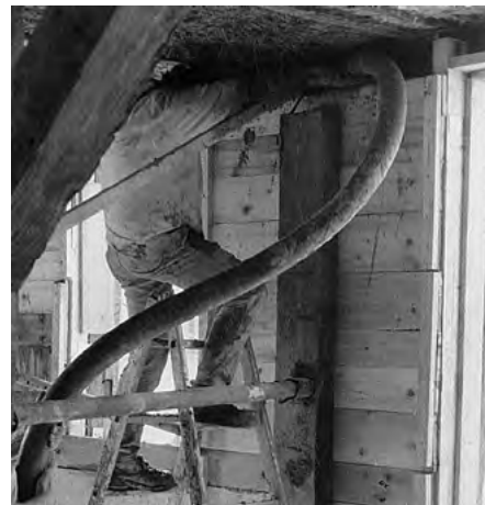
13.6-1 TRANSPORT MINERALNEJ GLINY LEKKIEJ PRZY POMOCY POMPY DO ZAPRAW
