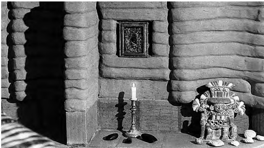
8.4-9 PLASTYCZNE UKSZTAŁTOWANIE ŚCIAN Z PASM GLINIANYCH POPRZEC WYCINANIE I DEFORMACJĘ
