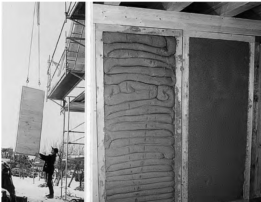
7.2-10 ELEMENTY ŚCIENNE WYSOKOŚCI KONDYGNACJI Z RAM DREWNIANYCH WYPEŁNIONYCH GLINĄ, PODAWANE DŹWIGIEM
