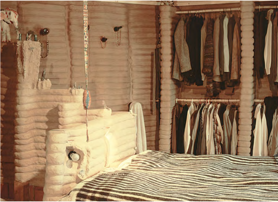
14.10-3 PLASTYCZNIE UFORMOWANA ŚCIANA Z PASM GLINIANYCH, STANOWIĄCA TYŁ ŁÓŻKA
