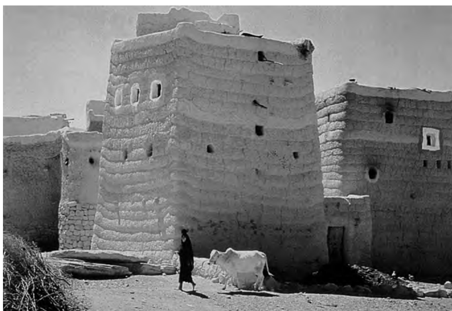
8.2-9 DOMY W JEMENIE PÓŁNOCNYM ZBUDOWANE TECHNIKĄ „ZABUR”)
