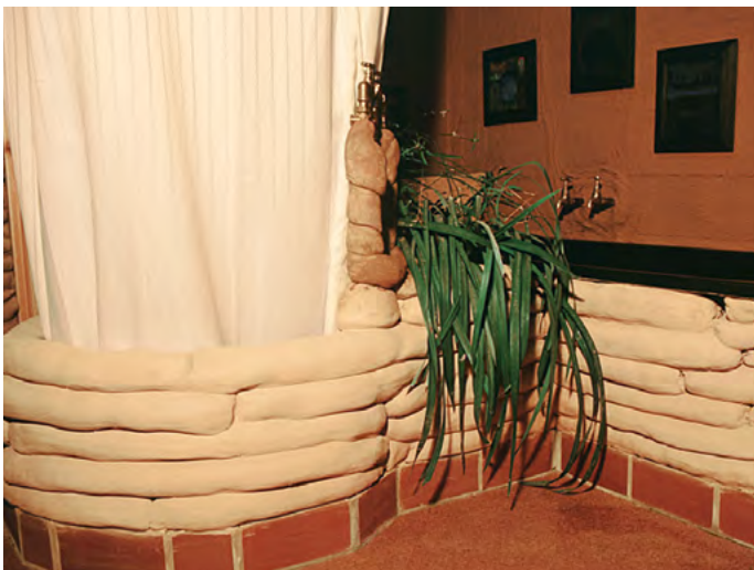
14.10-6 ELEMENTY SANITARNE OTULONE RĘKAWAMI Z GLINĄ LEKKĄ
