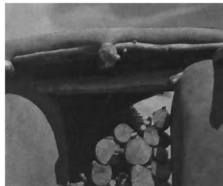
11.13-1 TYNK GLINIANY, STABILIZOWANY EMULSJĄ BITUMICZNĄ, NA BUDYNKU MIESZKALNYM W SANTA FE, USA
