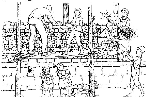
8.3-1 SPOSÓB BUDOWANIA ZWANY „CHLEBY GLINIANE Z DÜNNE”, DOMOSTWO W DÜNNE
