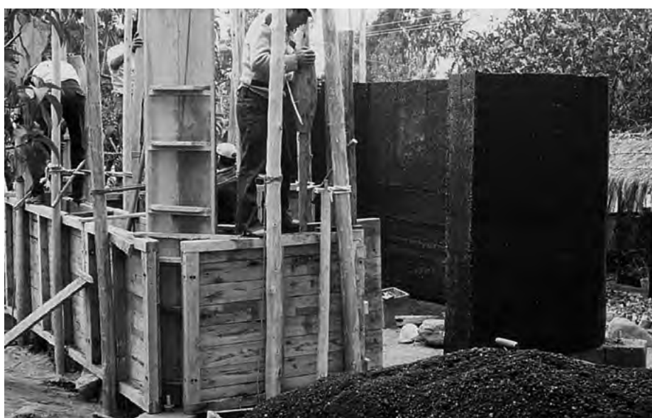
10.5-1 BUDOWA UBIJANEJ ŚCIANY Z GLINY LEKKIEJ Z PUMEKSEM, PUJILI, EKWADOR
