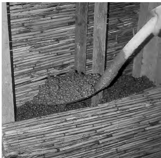
10.5-10 WYPEŁNIANIE GLINĄ LEKKĄ TRACONEGO DESKOWANIA, SŁUŻĄCEGO PÓŹNIEJ ZA PODKŁAD NOŚNY DLA TYNKU
