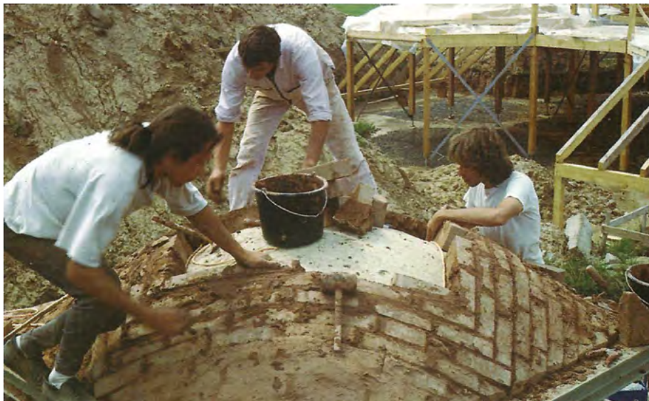
14.7-43 BUDOWA KOPUŁY Z CEGŁY GLINIANEJ NA FORMIE Z PIASKU
