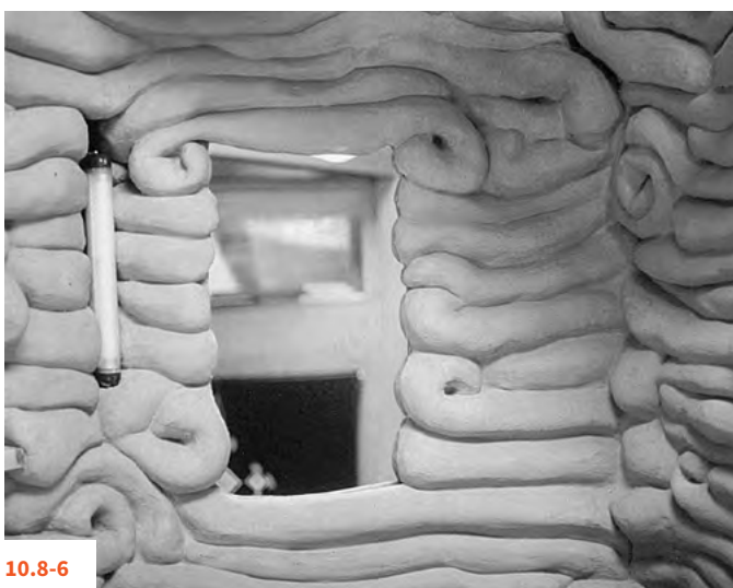
10.8-4 BUDOWA ŚCIANY ŁAZIENKI Z NAPEŁNIONYCH GLINĄ RĘKAWÓW
