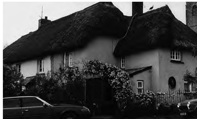
8.2-11 TYPOWY BUDYNEK POWSTAŁY PRZY ZASTOSOWANIU TECHNIKI „COB”, DEVON, ANGLIA, XVIII WIEK
