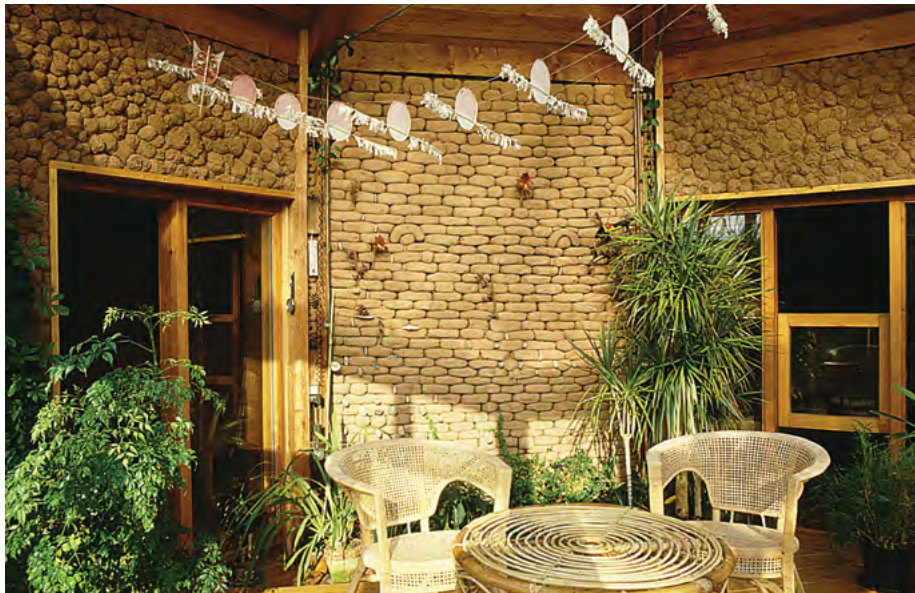
14.8-1 ŚCIANA Z NIEWYPALONYCH CEGIEŁ KUMULUJĄCA CIEPŁO
