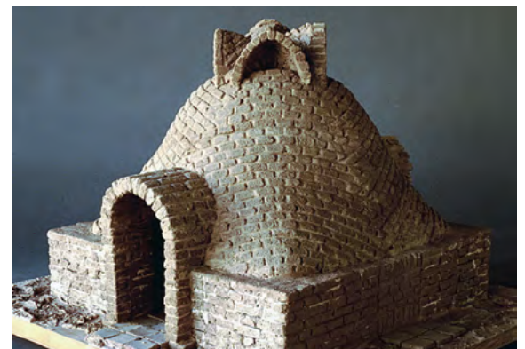
14.7-32 PERSKA KONSTRUKCJA KOPUŁY
