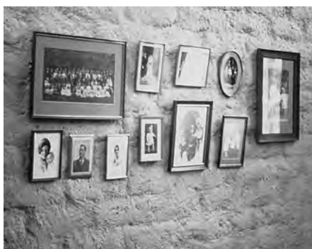
6.8-1 ŚCIANA Z CEGŁY GLINIANEJ POKRYTA SZLAMEM, DOM MIESZKALNY W BENDIGO, AUSTRALIA
