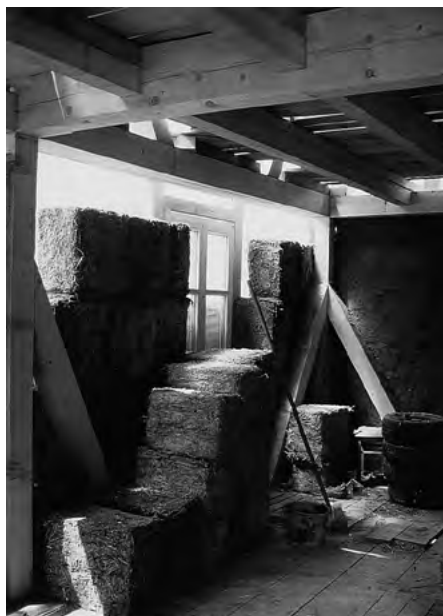
7.2-5 PRODUKCJA I ZABUDOWA WIELKOWYMIAROWYCH BLOKÓW Z GLINY ZE SŁOMĄ
