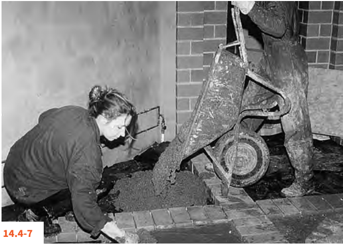
14.4-7 DO 14.4-8 KŁADZENIE I WYKOŃCZANIE POSADZKI Z NASYPYWANEJ, NADAJĄCEJ SIĘ DO CHODZENIA I ODPORNEJ NA ŚCIERANIE ZAPRAWY Z GLINY LEKKIEJ
