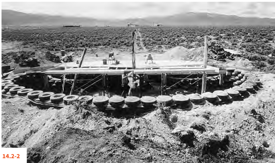
14.2-2 | 14.2-3 ŚCIANA Z WYPEŁNIONYCH GLINĄ STARYCH OPON SAMOCHODOWYCH, USA
