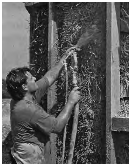
11.9-1 NANOSZENIE PIERWSZEJ WARSTWY TYNKU
