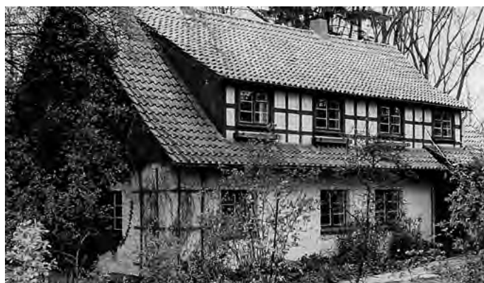
8.3-4 BUDYNEK MIESZKALNY WEERTZ, W MIEJSCOWOŚCI DÜNNE
