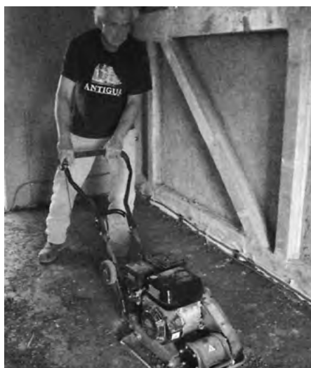
14.4-11 ZAGĘSZCZANIE POSADZKI GLINIANEJ PRZY POMOCY LEKKIEGO WIBRATORA
