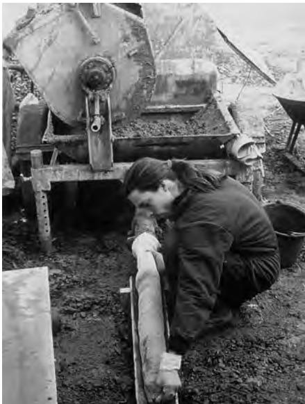
10.8-1 NAPEŁNIANIE BAWĘLIANYCH RĘKAWÓW GLINĄ LEKKĄ PRZY POMOCY POMPY ŚLIMAKOWEJ
