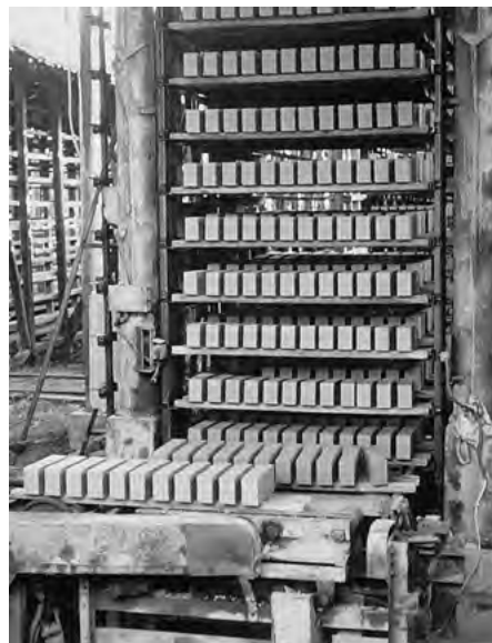
6.4-14 SUSZENIE NA POWIETRZU CEGIEŁ ZIELONEK, CEGIELNIA GUMBEL, GILSERBERG, NIEMCY
