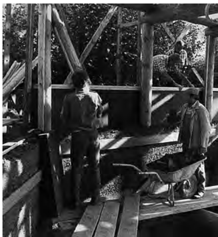
10.2-4 BUDOWA ŚCIANY Z GLINY LEKKIEJ BEZ DESKOWANIA WEWNĘTRZNEGO
