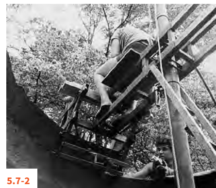
5.7-2 | 5.7-3 WYKONYWANIE KOPUŁY Z UBIJANEJ GLINY PRZY POMOCY ROTACYJNEGO DESKOWANIA ŚLIZGOWEGO
