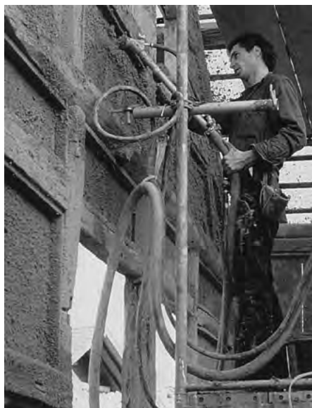
9.3-1 WYPEŁNIANIE PRZESTRZENI MIĘDZYKONSTRUKCYJNEJ TYNKIEM GLINIANYM LEKKIM
