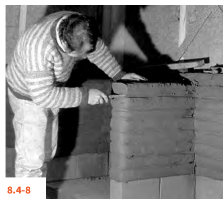
8.4-5 DO 8.4-8 PRODUKCJA I UKŁADANIE PASM LINIANYCH
