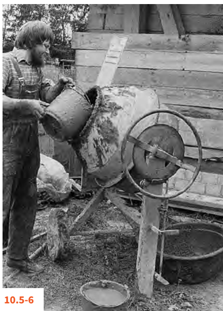
10.5-6, 10.5-7 MIESZANIE GLINY LEKKIEJ Z DODATKAMI MINERALNYMI W BETONIARCE WOLNOSPADOWEJ I WSYPIWANIE DO SZALUNKU
