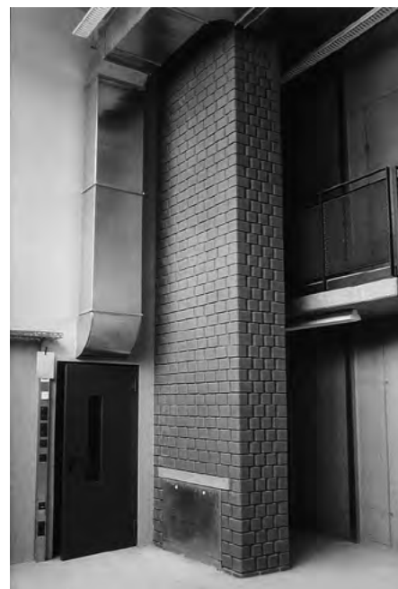
6.11-3 ŚCIANA O WYSOKOŚCI 6 M Z AKUSTYCZNYCH CEGIEŁ GLINIANYCH, CENTRUM BUDOWNICTWA EKOLOGICZNEGO, KASSEL, NIEMCY
