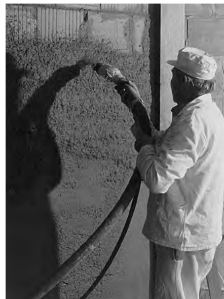
11.6-1 NAKŁADANIE TYNKU LEKKIEGO PRZY POMOCY AGREGATU TYNKARSKIEGO
