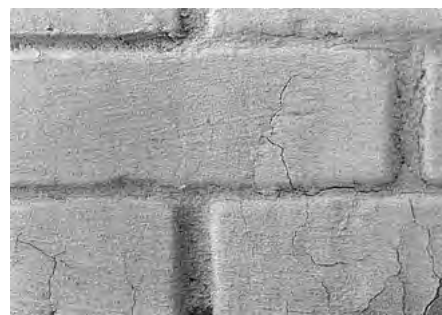
6.5-3 TWORZENIE SIĘ RYS NA POMALOWANEJ ŚCIANIE PO WYSCHNIĘCIU PRZEMOCZONYCH ZIELONEK
