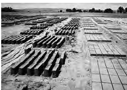
6.4-12 | 6.4-13 PRODUKCJA CEGIEŁ GLINIANYCH HANS SUMPFF, USA
