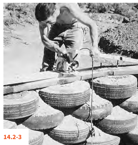
14.2-2 | 14.2-3 ŚCIANA Z WYPEŁNIONYCH GLINĄ STARYCH OPON SAMOCHODOWYCH, USA
