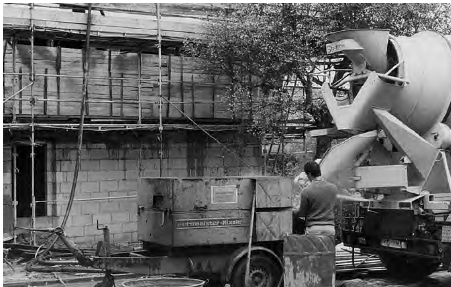
10.5-15 POMPOWANIE GLINY LEKKIEJ Z DODATKAMI MINERALNYMI
