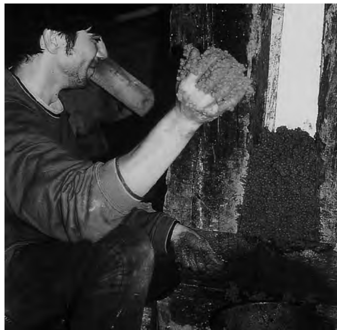
10.5-11 WRZUCANIE GLINY LEKKIEJ Z DODATKAMI MINERALNYMI DO DESKOWANIA MAŁEGO ELEMENTU
