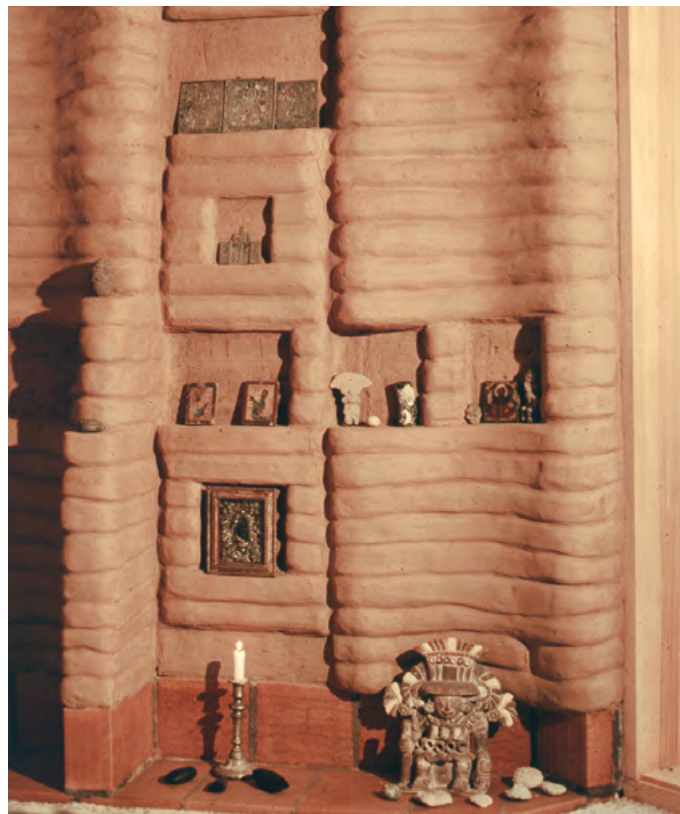
14.10-2 ŚCIANA Z PASM GLINIANYCH, KTÓREJ ZDOBIENIA WYKONANO W CZASIE JEJ WYSYCHANIA
