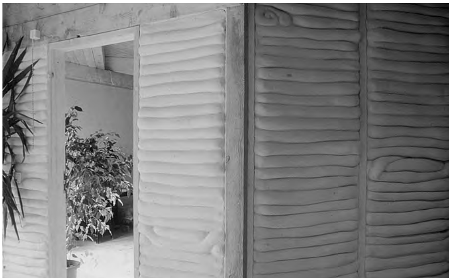
10.8-8 ŚCIANA WEWNĘTRZNA Z RĘKAWÓW NAPEŁNIONYCH GLINĄ
