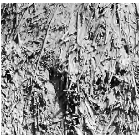
11.9-2 WYGŁADZONA POWIERZCHNIA TYNKU PO PIERWSZYM NATRYSKU
