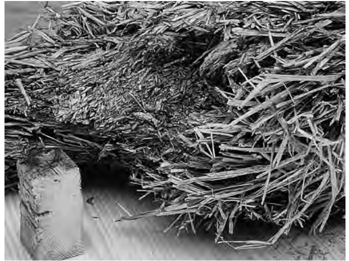
10.3-3 FRAGMENT ZBUTWIAŁEJ ŚCIANY Z GLINY LEKKIEJ ZE SŁOMĄ
