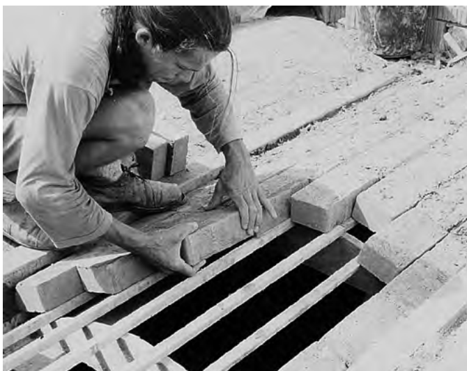
14.7-41 | 14.7-42 BUDOWA SKLEPIENIA ODCINKOWEGO NA DESKOWANIU
