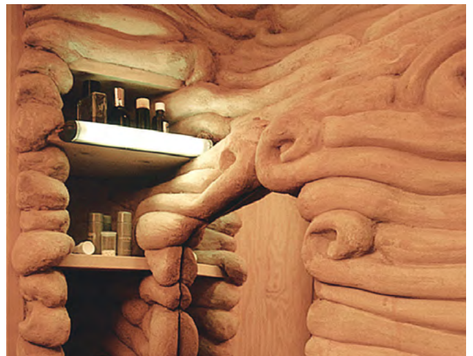
14.10-7 REGAŁY, LUSTRO I LAMPKA WBUDOWANE W ŚCIANĘ Z RĘKAWÓW GLINIANYCH
