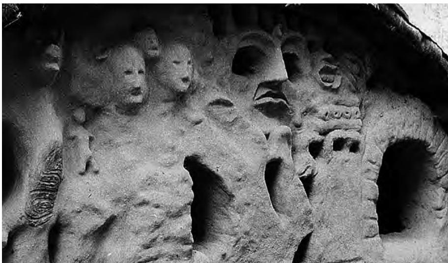
8.4-11 ŚCIANY Z PASM GLINIANYCH UFORMOWANE PLASTYCZNIE PRZEC WYCINANIE I RZEźBIENIE
