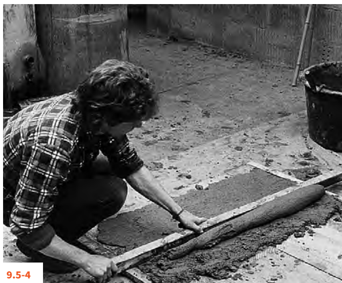
9.5-4 DO 9.5-6 WSPÓŁCZESNY SPOSÓB BUDOWANIA PRZY UŻYCIU TYCZEK OWINIĘTYCH GLINĄ
