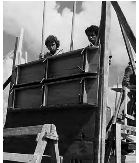
5.6-12 BUDOWNICTWO O KONSTRUKCJI RAMOWEJ ZE ŚCIANAMI WYPEŁNIAJĄCYMI Z GLINOBITKI, CEPED; BRAZYLIA
