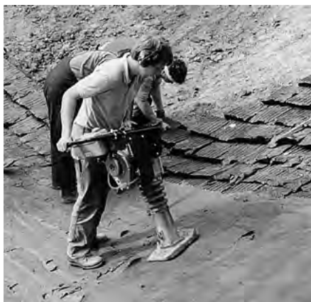
14.14-1 UKŁADANIE PREFABRYKATÓW GLINIANYCH JAKO ELEMENTÓW USZCZELNIAJĄCYCH STAW (FIRMA DIEKMANN, PEINE, NIEMCY)
