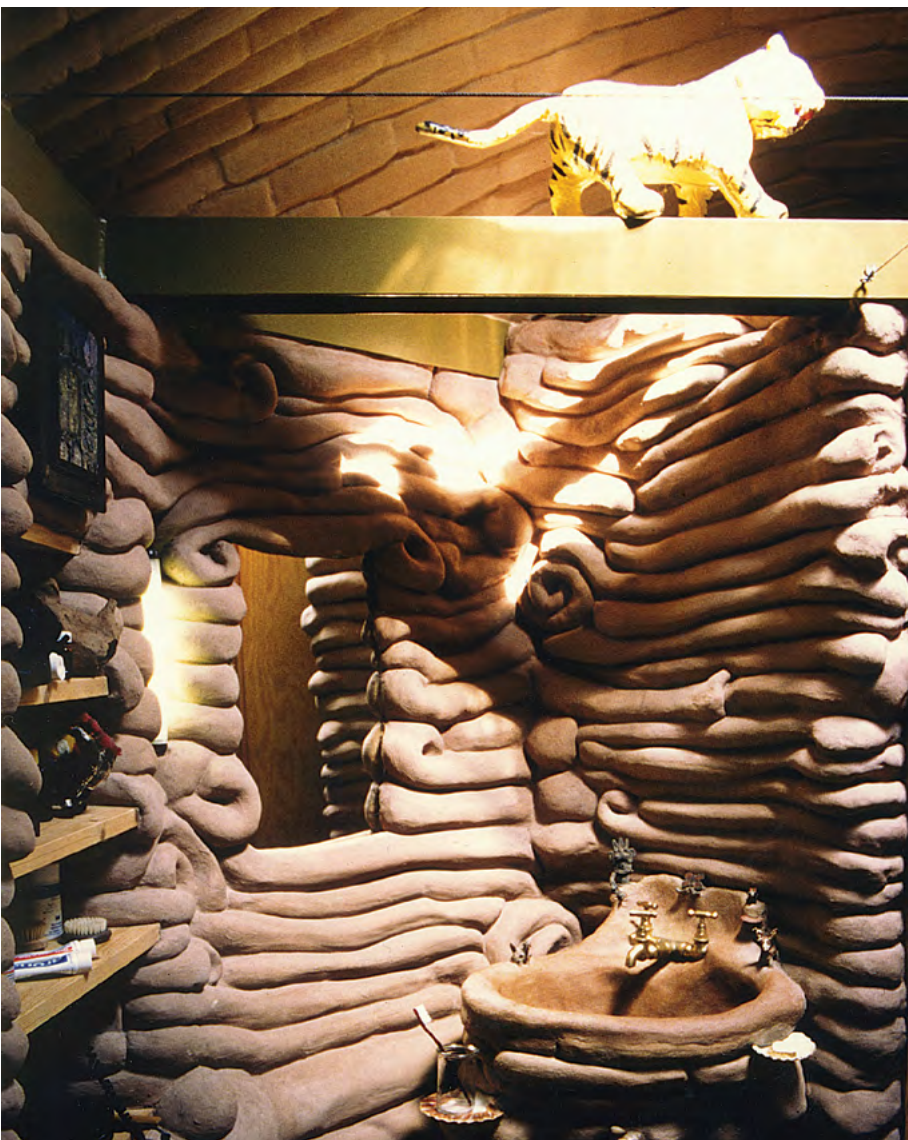
14.9-2 ŁAZIENKA Z GLINIANYMI ŚCIANAMI I GLINIANYM SKLEPIENIEM
