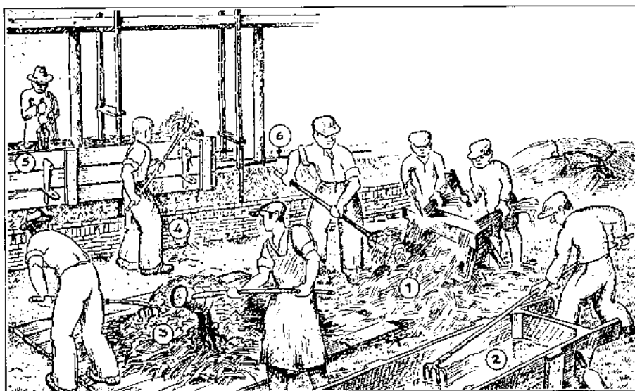
10.3-1 ORGANIZACJA BUDOWY PRZY ZASTOSOWANIU GLINY LEKKIEJ ZE SŁOMĄ (FAUTH 1948) OPIS NA RYSUNKU: WYKONANIE ŚCIANY Z GLINY LEKKIEJ:
