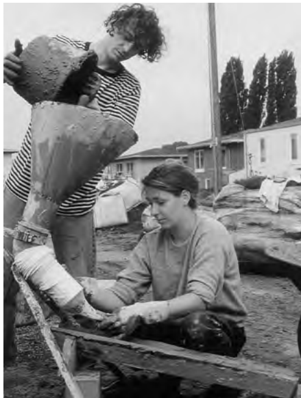
10.8-2 RĘCZNE NAPEŁNIANIE BAWĘLIANYCH RĘKAWÓW GLINĄ LEKKĄ
