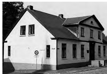
1.2-12 FASADY BUDYNKÓW Z UBIJANEJ GLINY BAHNHOFSTR., WELBURG, OK. 1830
