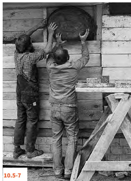
10.5-6, 10.5-7 MIESZANIE GLINY LEKKIEJ Z DODATKAMI MINERALNYMI W BETONIARCE WOLNOSPADOWEJ I WSYPIWANIE DO SZALUNKU
